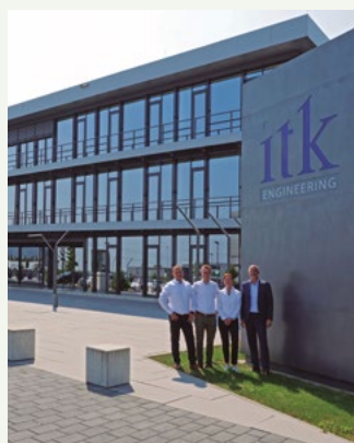
ITK Engineering GmbH. En innovativ kontorbygning i Tyskland. ECOi - PACi
